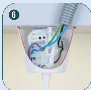
6 Установка актуатора в коробке светильника
