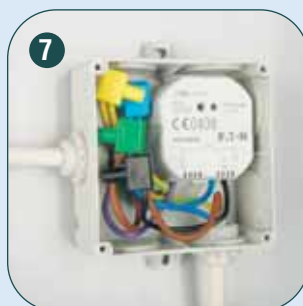
7 Установка актуатора во влагозащищенной коробке
